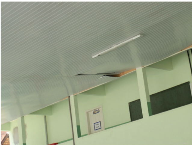
Exemplo 1: Abertura das juntas de forro PVC
